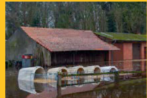
Die Kälber mussten schon zu Beginn der Fluten in den noch intakten Kuhstall gebracht werden.
